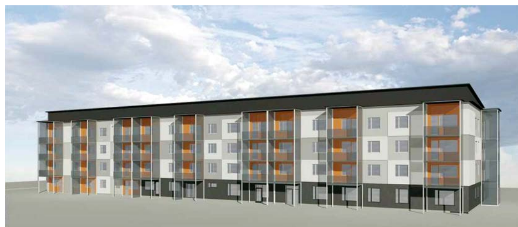
3.38. attēls. Ēka pēc pilnas renovācijas ar koka elementu fasādi, jauniem balkoniem un jaunu slīpo jumtu (avots: K. Lilikangass)
