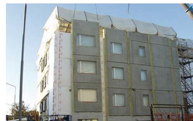
3.35. attēls. Ar cauruļu pagaidstruktūru aizsargāts jumts
