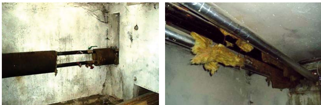
3.11. attēls. Mustamē, Sōpruse 244, ēkas apkures sistēma (pa kreisi) un ūdens caurules (pa labi) pirms renovācijas
