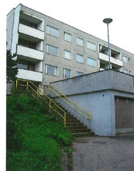
3.26. attēls. Skats uz kāpņutelpu un balkonu no ēkas vienas puses
