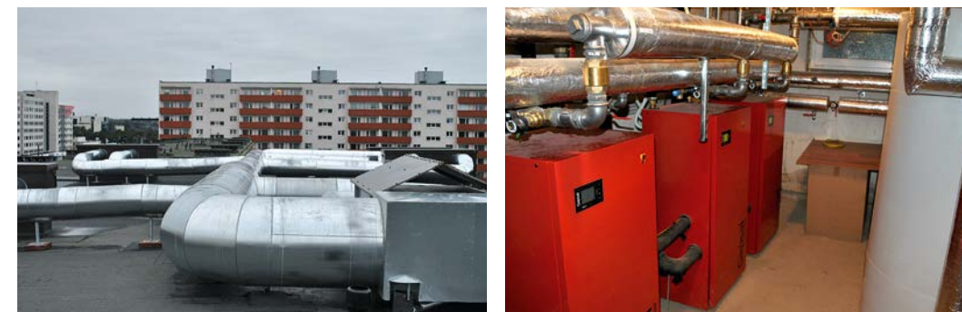
3.13. attēls. Ēka Mustamē, Sōpruse 244, pēc renovācijas. Vēdes kanāli pie jumta (pa kreisi), uzstādītie siltumsūkņi (pa labi)
