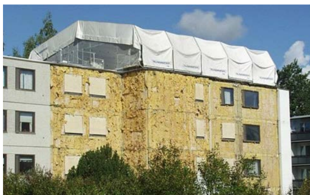
3.34. attēls. Vecās izolācijas noņemšana un fasādes ārējā paneļa nojaukšana
