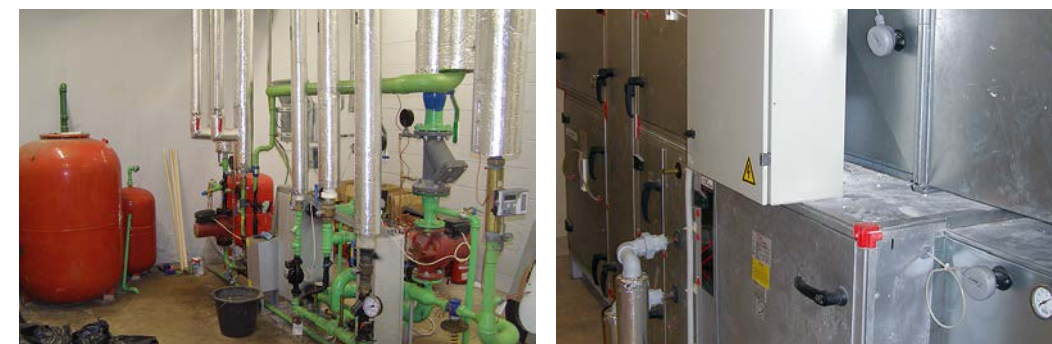
3.21. attēls. Moderna apkures apakšstacija (pa kreisi) un gaisa apstrādes vienība ar gaisa utilizācijas iespējām (pa labi)
