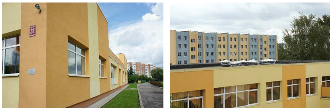
3.6. attēls. Renovētais bērnudārzs Jelgavā
