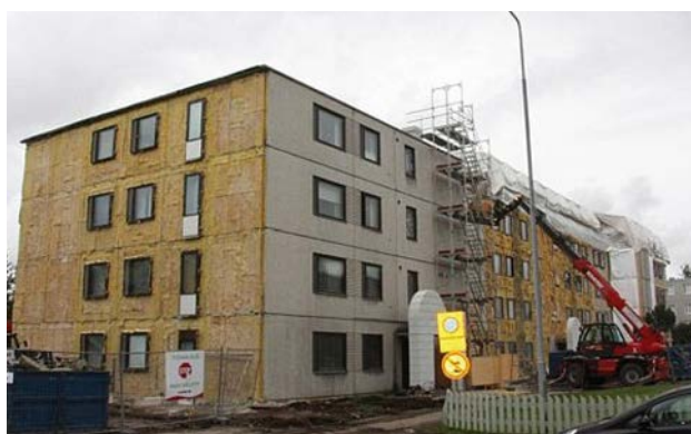
3.33. attēls. Vecās izolācijas noņemšana un fasādes ārējā paneļa nojaukšana
