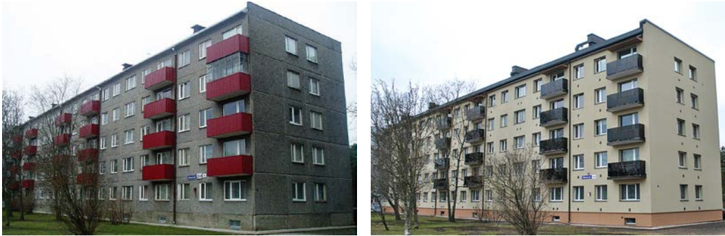
3.10. attēls. Ēka Mustamē, Sõpruse 244, pirms (attēls pa kreisi) un pēc (attēls pa labi) renovācijas
