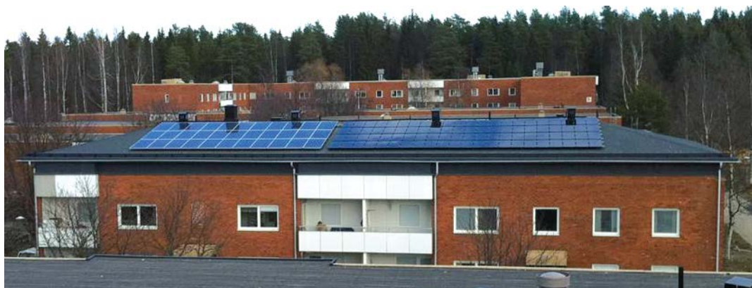
3.49. attēls. Divas saules bateriju sistēmas: kristāliskā silīcija moduļi – pa kreisi, plānās plēves moduļi – pa labi [3]
