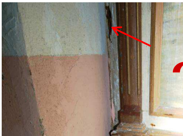
Foto 185. Pruunmädanikku tekitava seene kahjustus ikooniseina esiküljel
