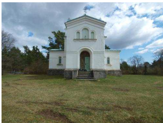
Foto 199. Üldvaade hoone peasissekäigule ja kirdepoolsele küljele
