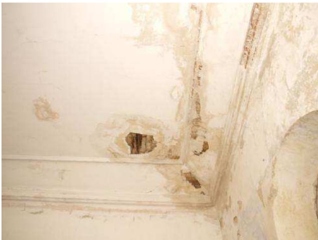
Foto 64. Kahjustatud krohv kiriku saalihalli laes
