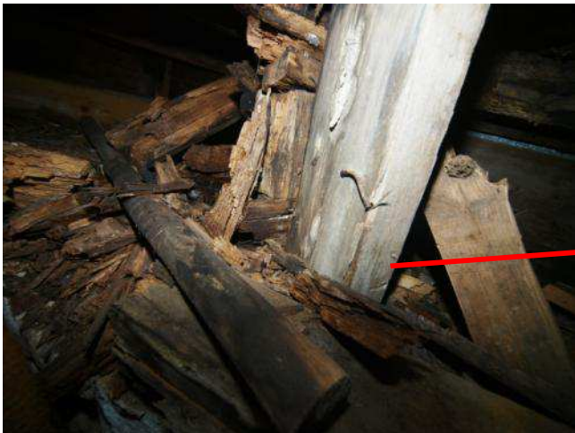
Foto 96. Keskmise kupli laetarind
