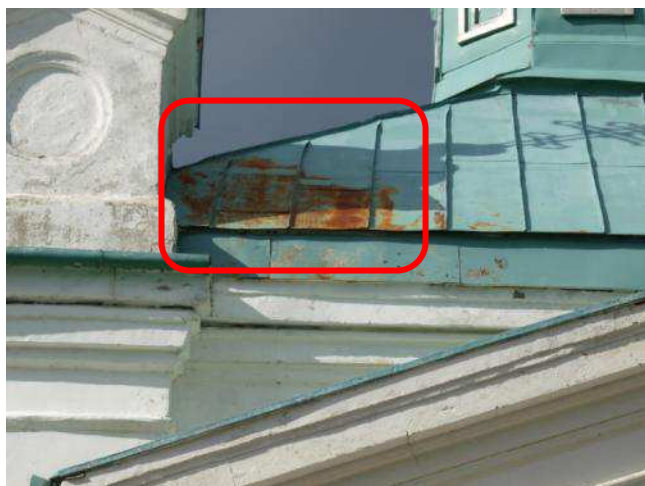
Foto 201. Korrodeerunud katuseplekk
