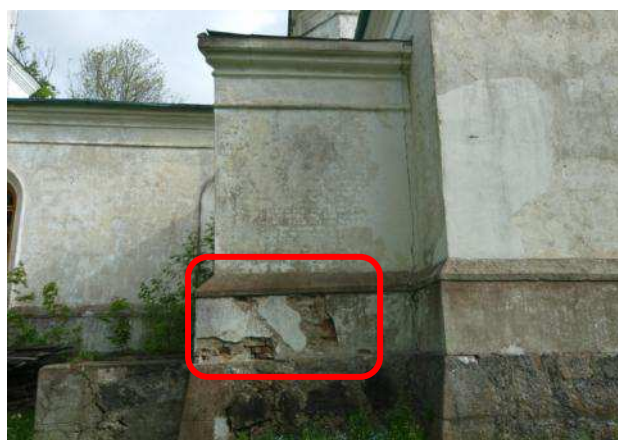
Foto 80. Kahjustatud krohv seina alumises osas
