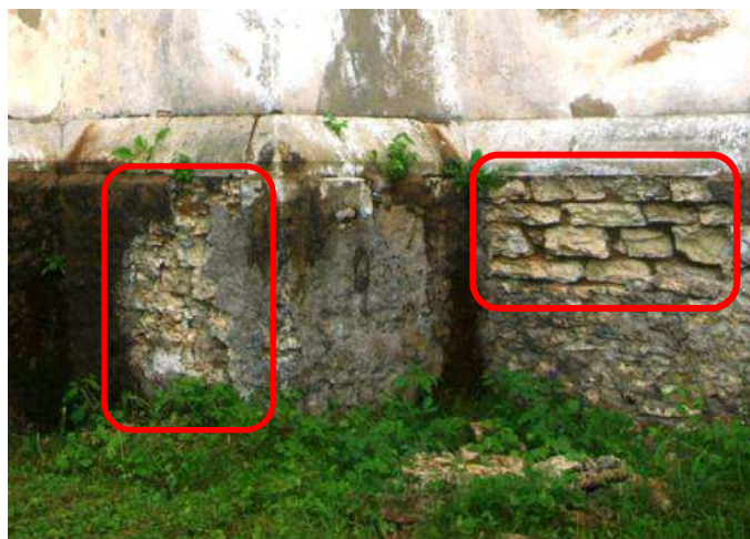
Foto 161. Irdunud müürimört kiriku soklil
