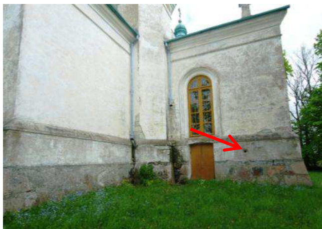
Foto 83. Välisõhuga tuulutatav altariruumi põrand
