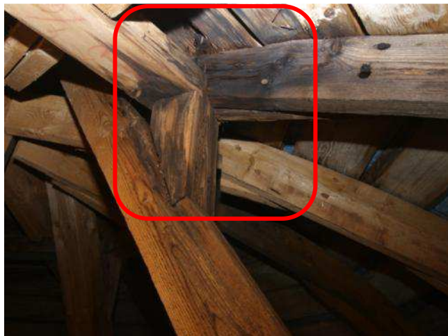
Foto 98. Seente poolt lagundatud keskmise kupli laetarindi sõlm
