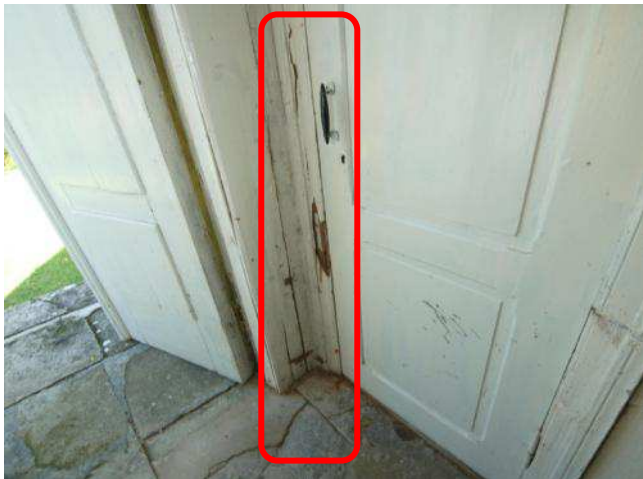
Foto 166. Pruunmädanikku tekitava seene kahjustus ukse lengil
