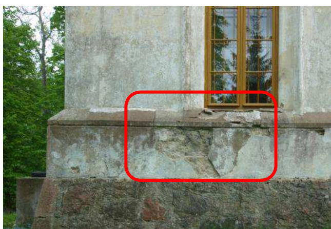
Foto 79. Kahjustatud krohv seina alumises osas
