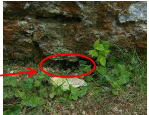
Foto 118. Kinnimüüritud põranda tuulutussava
