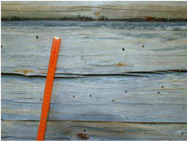
Foto 16. Mardikate väljalennuavad kabeli palkseinas
