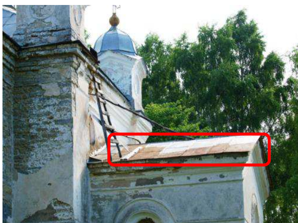
Foto 164. Korrodeerunud katuseplekk
