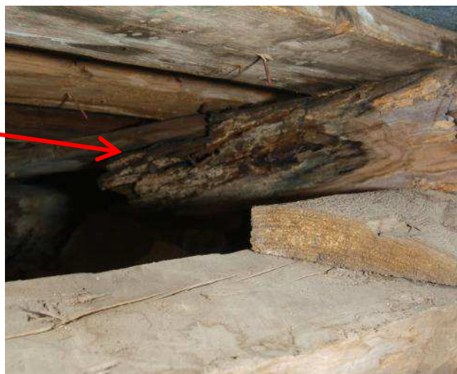
Foto 114. Seente poolt lagundatud puittarind
