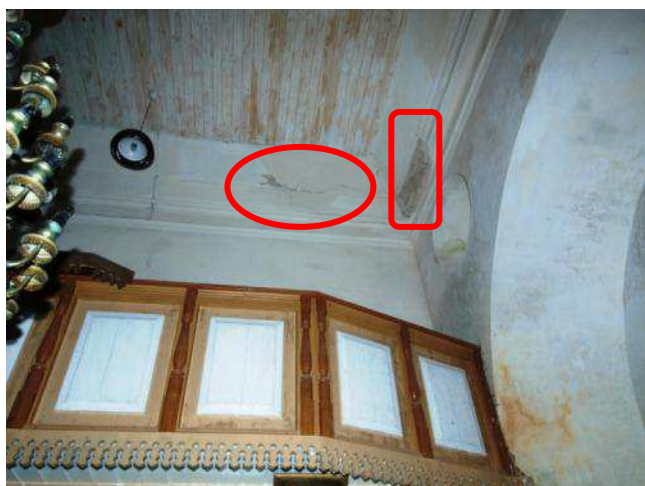
Foto 189. Varisenud ja varisemisohhtlik krohv kooripealse lael
