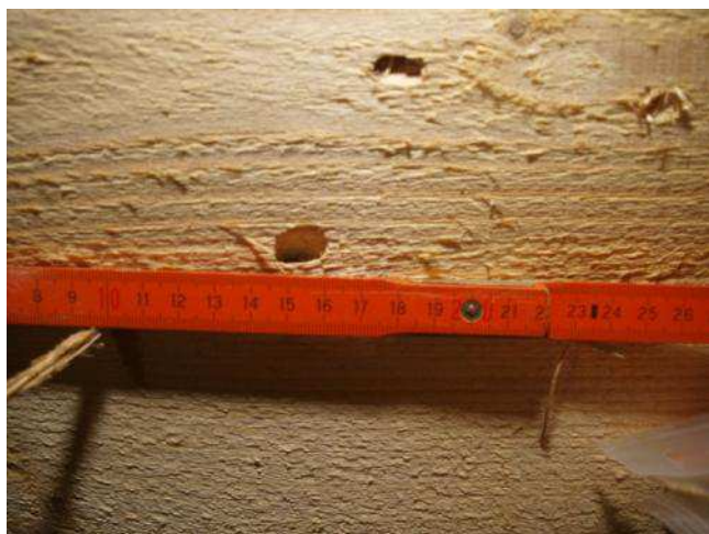
Foto 9. Majasiku väljalennuava kagukülje katusealuse roovituse laual
