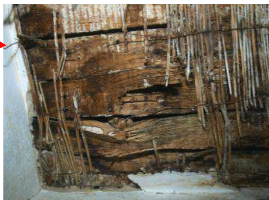
Foto 213. Seenkahjustus puittarindil
