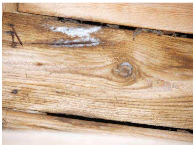
Foto 198. Niiskus- ja seenkahjustus lae puittarindil
