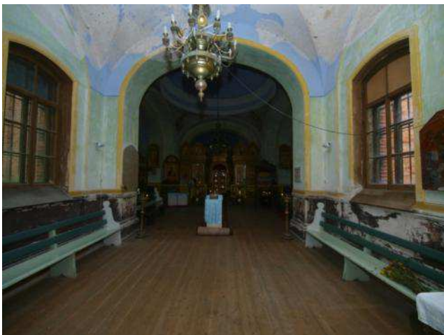
Foto 69. Kahjustatud värv ja krohv siseseintel
