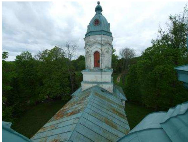
Foto 86. Korrodeerunud katusekate
