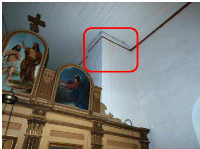
Foto 130. Vee läbijooksu jälg lõunakülje seinal
