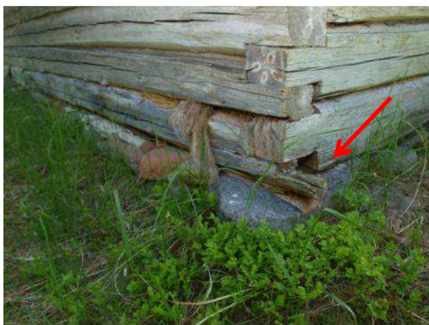
Foto 14. Pruunmädanikku tekitava seene kahjustus kabeli põhjapoolsel nurgal
