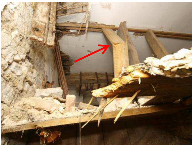
Foto 177. Kandevoime kaotanud kellatorni laetarindi element
