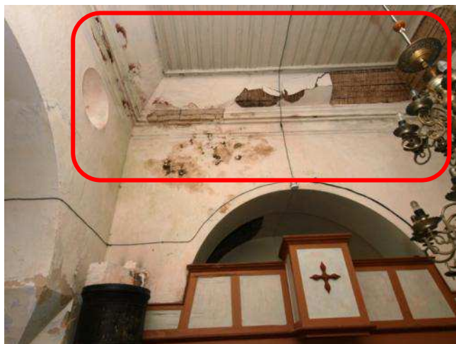
Foto 169. Kahjustatud krohv kooripealsel
