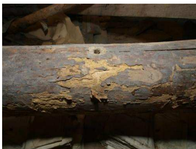
Foto 110. Seenkahjustus puittarindil
