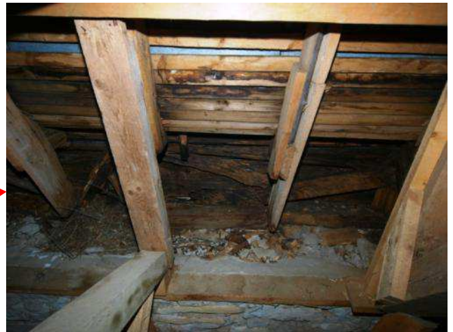
Foto 97. Keskmise kupli laetarindi müürilatt
