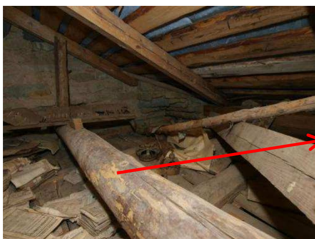
Foto 109. Puittarind kirikusaali pööningul
