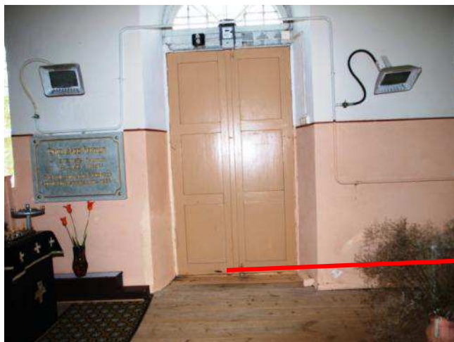
Foto 130. Vee läbijooksu jälg lõunakülje seinal
