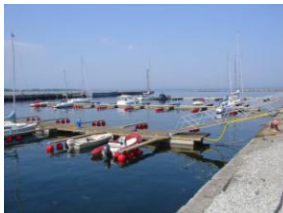
Joonis 3.12.3 Kõrvuti on uued ujuv- ja vanad betoonikaid
