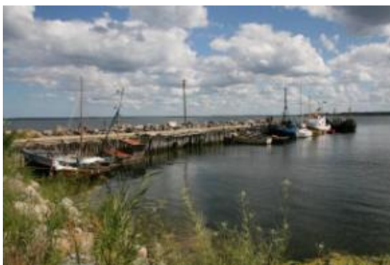
Joonis 3.20.2 Kivikastidele ehitatud kai laguneb
