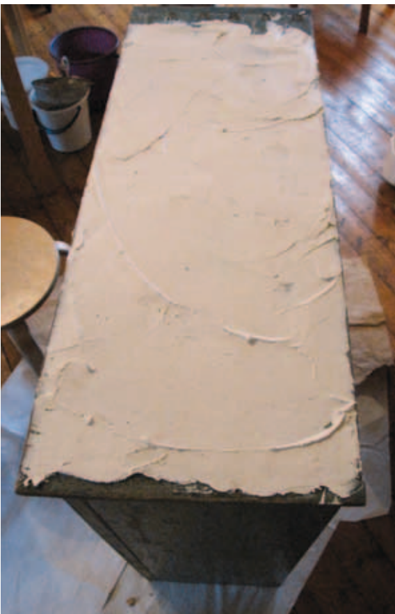
Maalinpoisto kalkilla ja saippuatahnalla.
