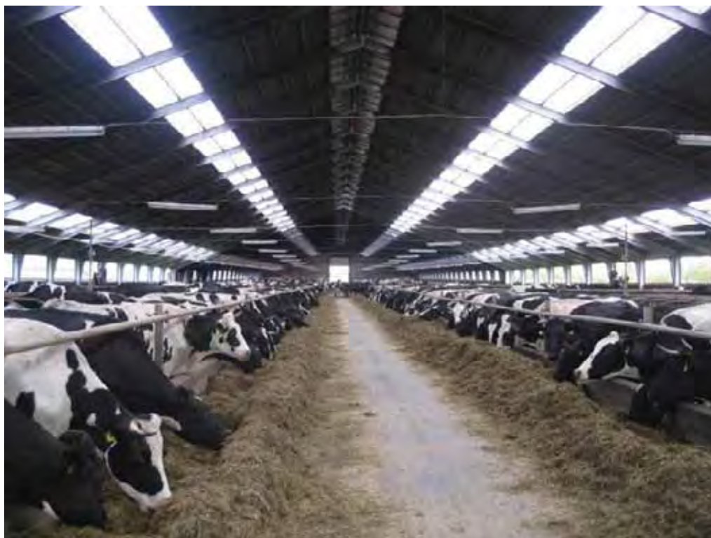
Kuva 3.29: Mallitilan ruokintapöydän valaistuksen tehostamiseksi käytetään valoa läpäiseviä kattopaneeleja
