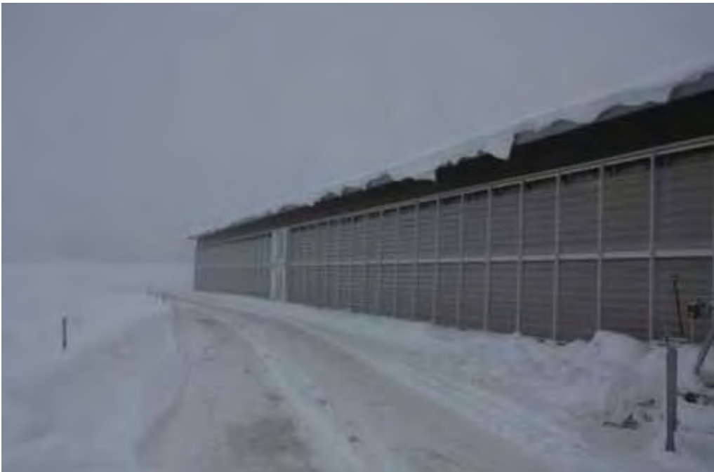
Kuva 3.31: Mallitilan verhoseinissä on ilmalla täytettävät verhot
