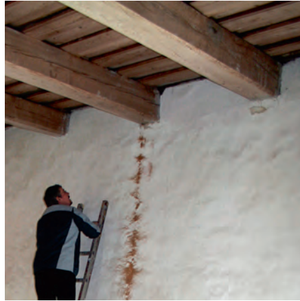
Foto 7. Mardikavastsete poolt kahjustatud laetalade otsad.
