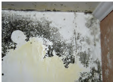
Foto 35. Hallitusseente kahjustus toanurgas, kus on tugev vee kondenseerumise probleem.
