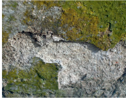
Foto 54. Tsüanobakterite, vetikate ja samblike koostoime tulemusena lagunenud krohvihiht.
