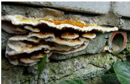
Foto 10. Majavammi viljakehad vundamendil, kõrval näha suletud tuulutusava.
