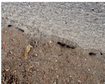
Foto 44. Mullamurelaste pesa maja vundamendi ääres.
