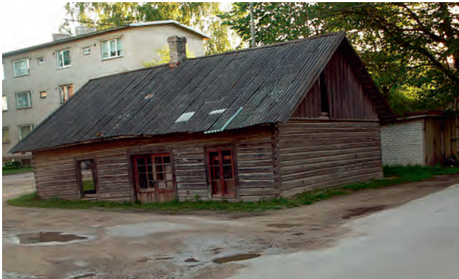
Foto 32. „Maasse vajunud“ hoone. Maapinna tõstmise tagajärg.
