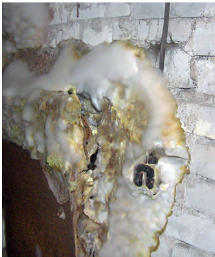
Foto 21. Seenediistik telliskiviseinal ja elektrijuhtmetel.
