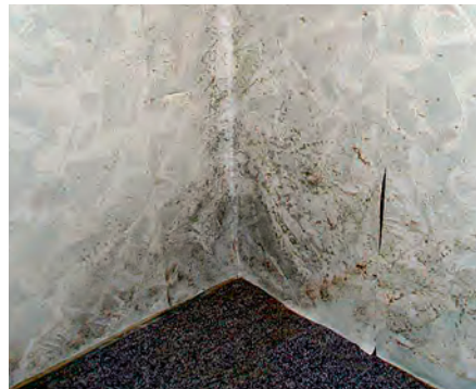
Foto 36. Kapiga varjatud jahedal väliseinal kondenseerub niiskuse ja arenevad hallitusseened.
